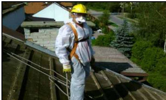
Fot. nr 3. Prace przy demontażu azbestu
