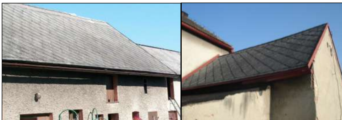
Fot. nr 7 i nr 8. Płyty azbestowo-cementowe typu "karo"
