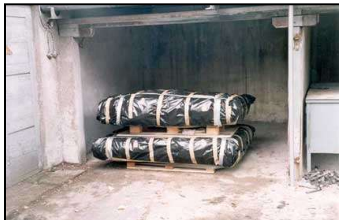
Fot. nr 4. Prawidłowo zapakowane odpady azbestowe
